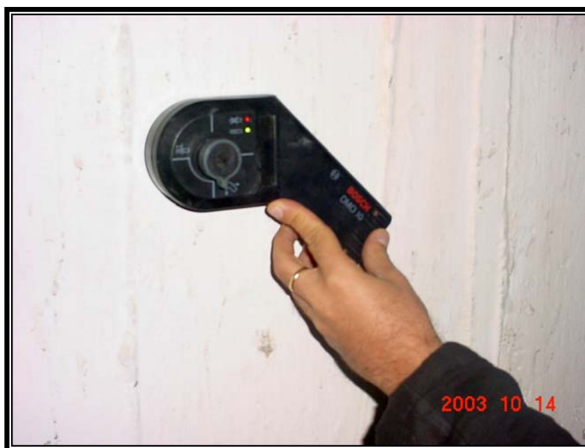
Figura 5.6: Locação do posicionamento de armadura utilizando pacômetro.
