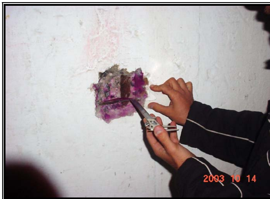
Figura 5.7: Medida do cobrimento de armaduras.
