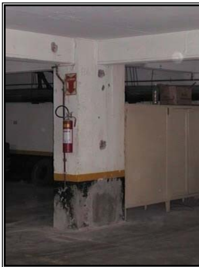
Figura 5.5: Vista de um dos pilares durante a realização dos ensaios.
