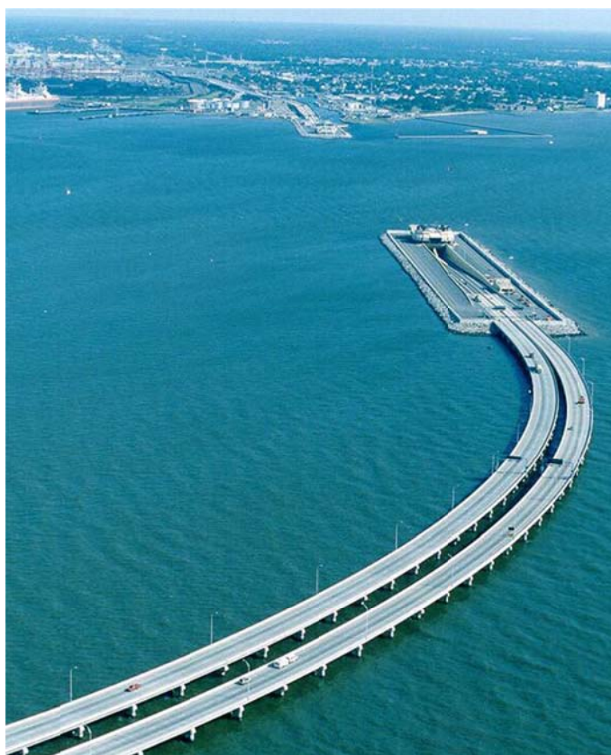
Figura 1 – Vista aérea da ponte e do emboque do túnel do Øresund Link 4 .
