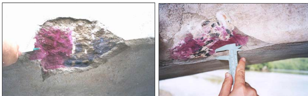
Figura 17 – Medida da profundidade de carbonatação do concreto com uso de indicadores químicos (fenolftaleína e timolftaleína) e paquímetro.
