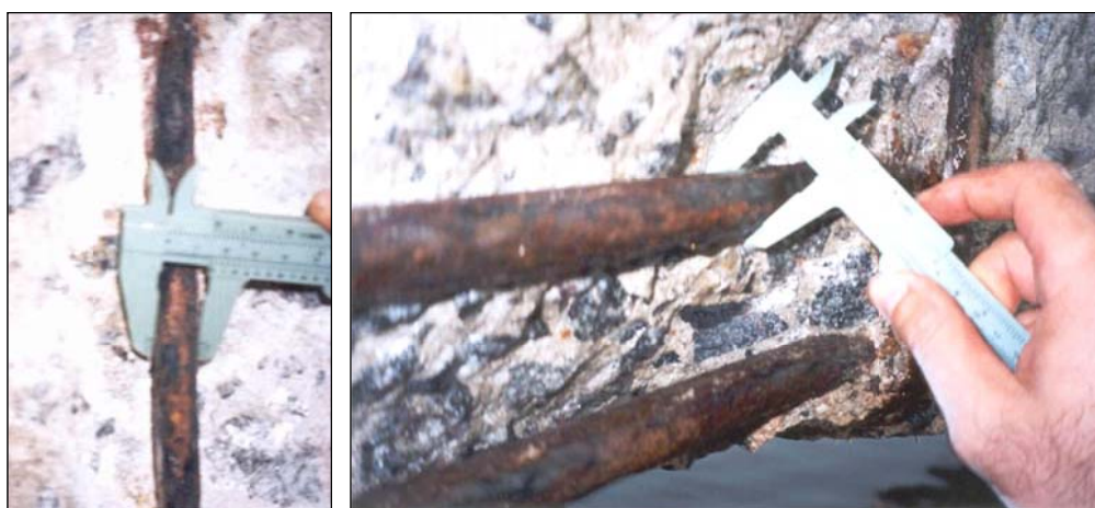
Figura 23 – Medida da redução de diâmetro das armaduras com paquímetro.
