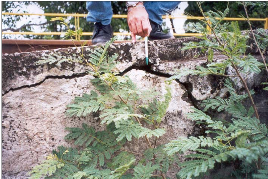
Fotografia 27 – Parede lateral de contenção do aterro do encontro Porto Velho, face SE. Notar rachadura indicando possível movimentação do aterro.!
