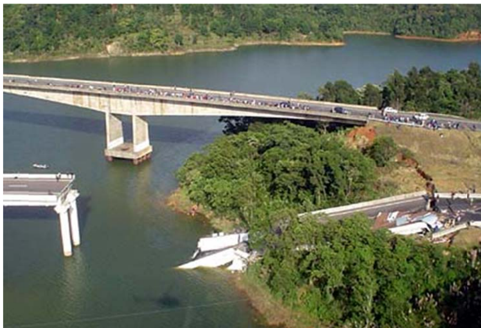
Figura 4 – Vista do vão que ruiu da ponte Capivari (BR-316) no dia seguinte ao acidente. Nota-se que o talude do encontro rompeu e “arrastou” os pilares do apoio extremo da ponte, provocando o colapso do vão em destaque. Notar, no fundo da fotografia, a ponte mais nova da outra pista da rodovia e a proximidade da linha de ruptura do talude (Nilton Fukuda – Agência Estado).
