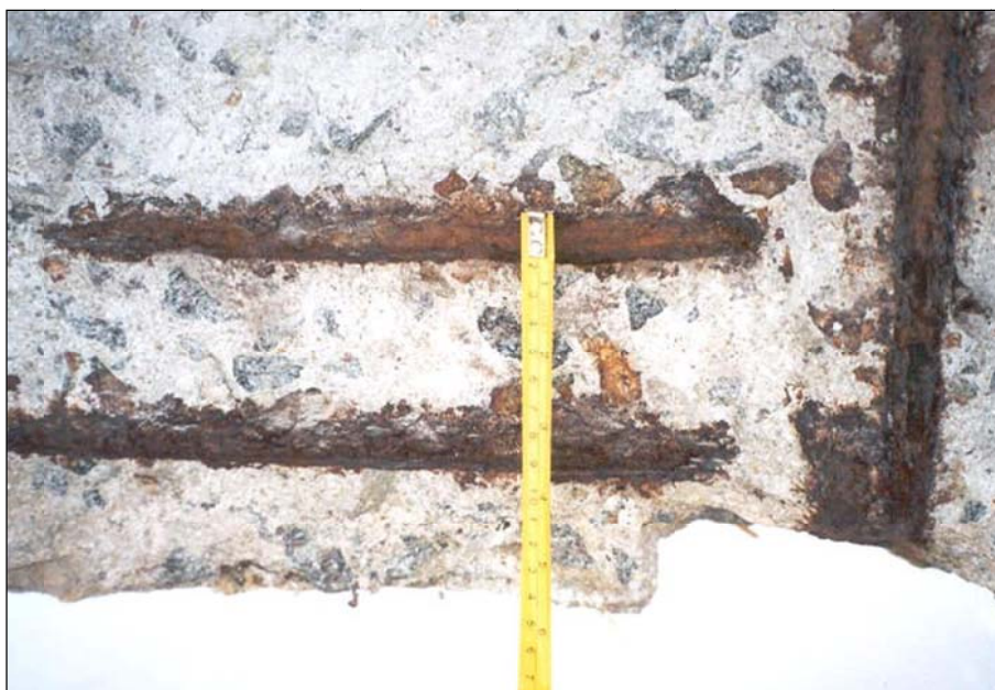
Fotografia 18 – Viga longitudinal L2, vão 2. Detalhe de estribo e das armaduras longitudinais mais externas da primeira e da segunda camada. Notar estágio avançado de corrosão e cor marrom-avermelhada dos produtos de corrosão.
