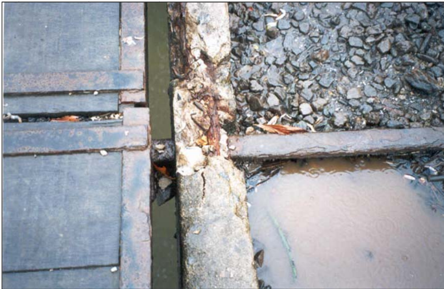
Fotografia 29 – Vista superior de viga transversal de apoio da passarela lateral. Notar estado de corrosão do perfil metálico e das armaduras da mureta lateral da laje.
