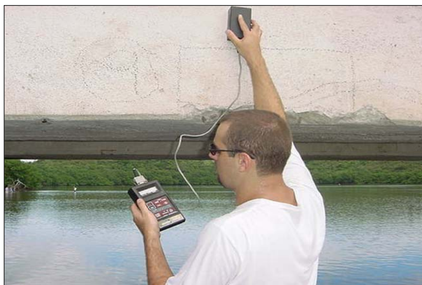
Figura 15 – Localização das armaduras com o uso de pacômetro.
