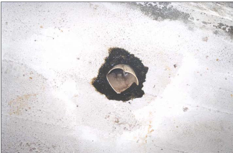
Fotografia 30 – Vista inferior de buzinote quebrado e com manchas laterais na laje, indicando má instalação do mesmo.
