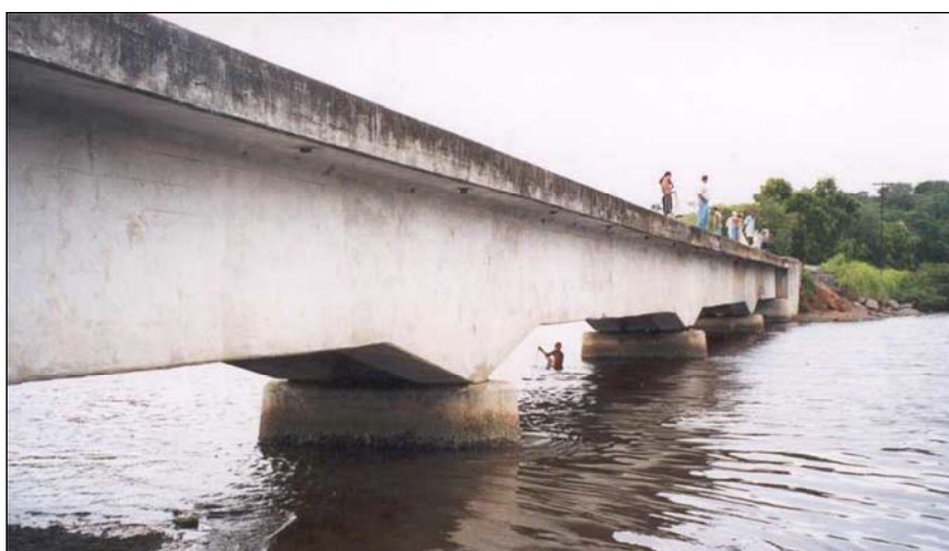
Figura 10 – Vista lateral, face sudeste.
