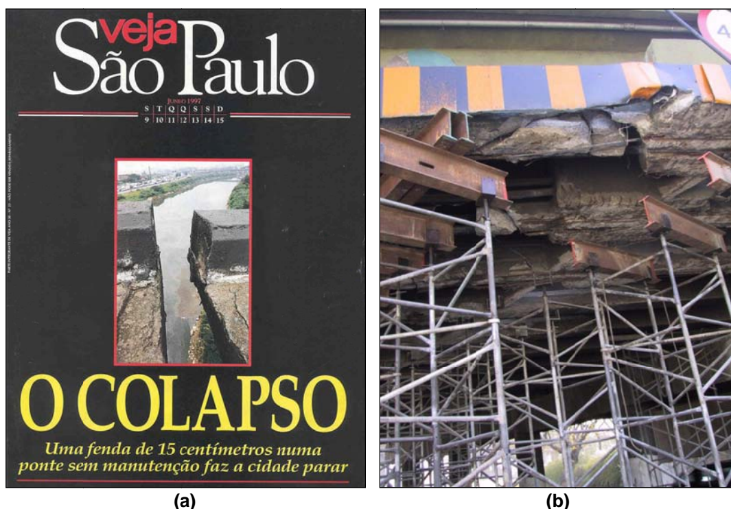
Figura 3 – (a) Capa da Revista Veja São Paulo da semana do acidente com a Ponte dos Remédios. Em destaque, nota-se a fenda de 15 cm que se abriu no vão central da ponte após a ruptura dos cabos de protensão. (b) Vista inferior do tabuleiro da Ponte Eusébio Matoso após o choque, com destaque para a destruição total das vigas longarinas externas e também para o escoramento provisório.
