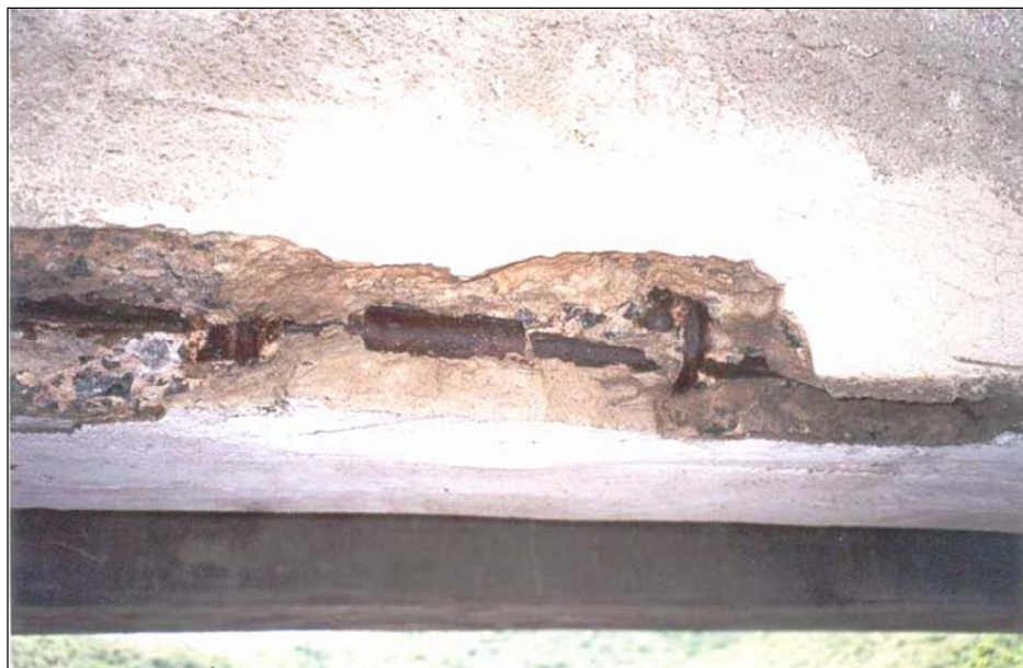
Fotografia 14 – Viga longitudinal L1, vão 3. Detalhe do destacamento do concreto de cobertura e exposição das armaduras principais e da luva de emenda (diâmetro maior).
