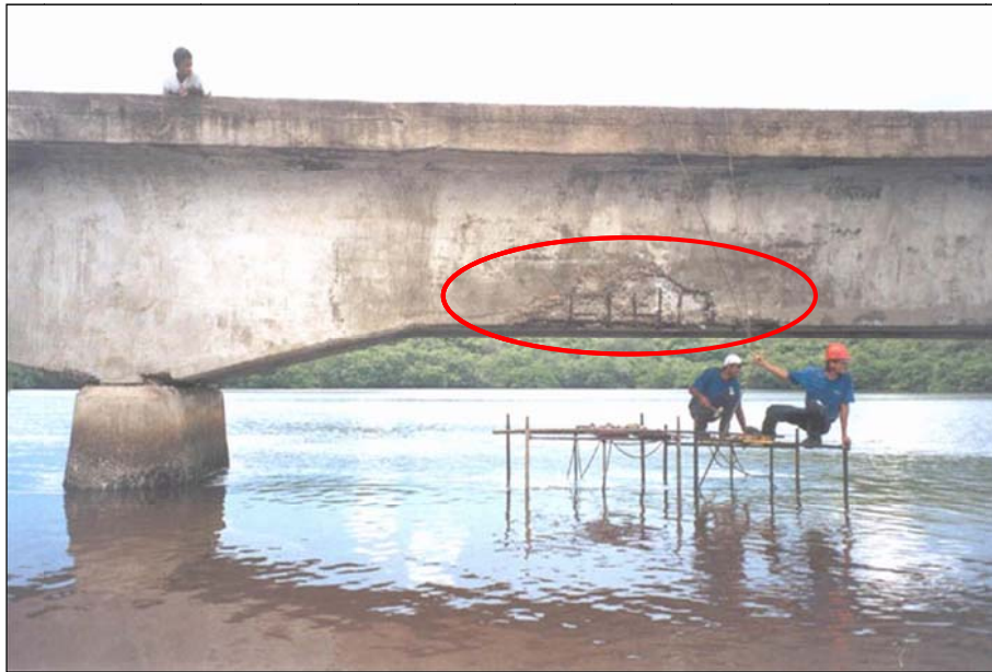
Fotografia 23 – Viga longarina L2, vão 3. Vista geral de área selecionada para estudo detalhado após remoção do concreto destacado e exposição das armaduras corroídas.
