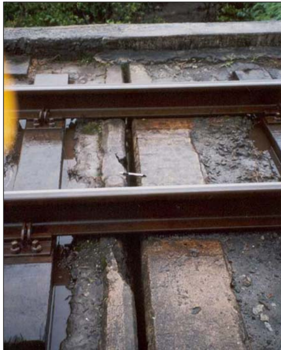
Fotografia 7 – Vista transversal, junta do encontro E1 (Porto Velho), notar abertura de 30 mm.
