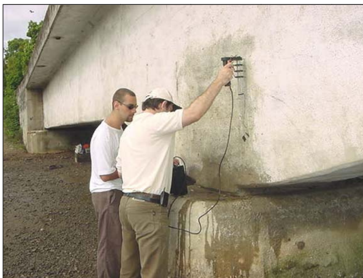
Figura 21 – Ensaio de resistividade elétrica do concreto.
