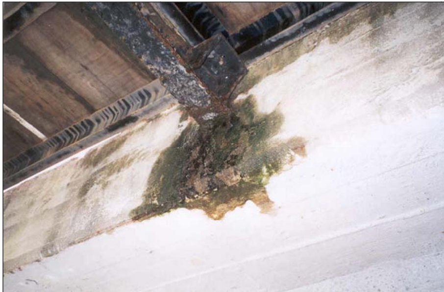
Fotografia 28 – Vista inferior de viga metálica transversal de apoio da passarela lateral. Notar estágio avançado de corrosão e manchas de umidade e musgos.
