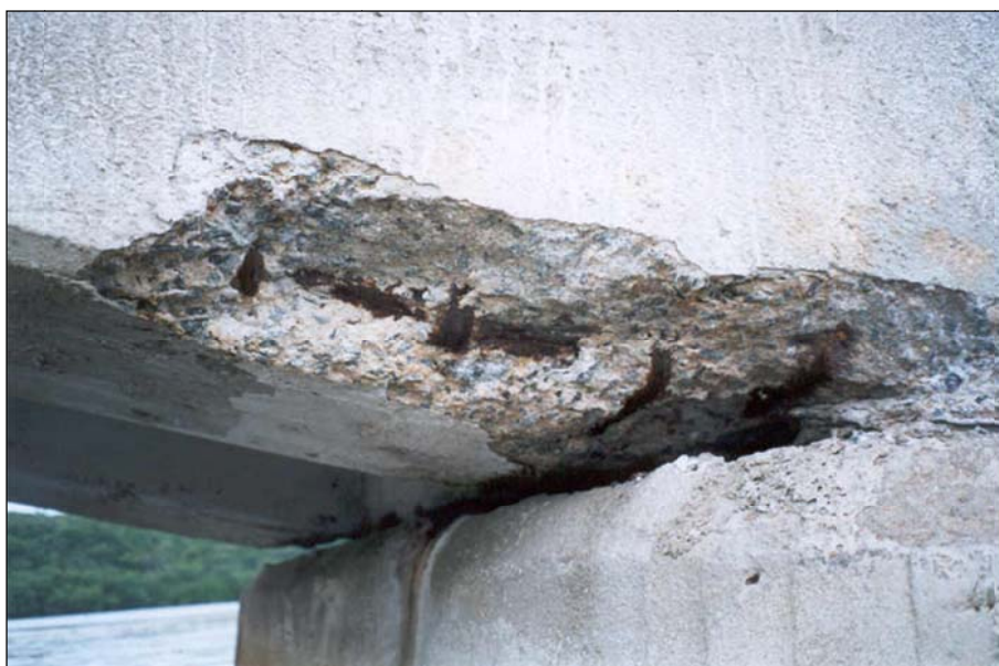
Fotografia 22 – Apoio da viga longitudinal L1 sobre o pilar P3. Detalhe da corrosão das armaduras do fundo da viga e do descolamento do concreto devido ao mau funcionamento do aparelho de apoio.
