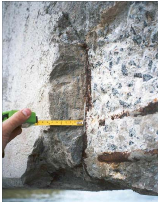
Fotografia 15 – Viga longarina L1, vão 3. Destacamento do material de reparo e exposição das armaduras corroídas. Detalhe da espessura da camada de reparo sobre concreto original.
