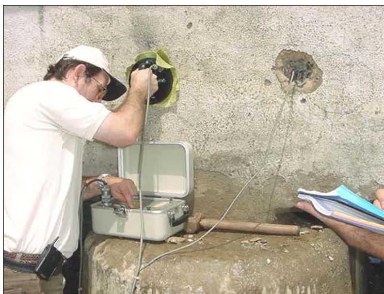
Figura 22 – Ensaio de corrente de corrosão por resistência de polarização.
