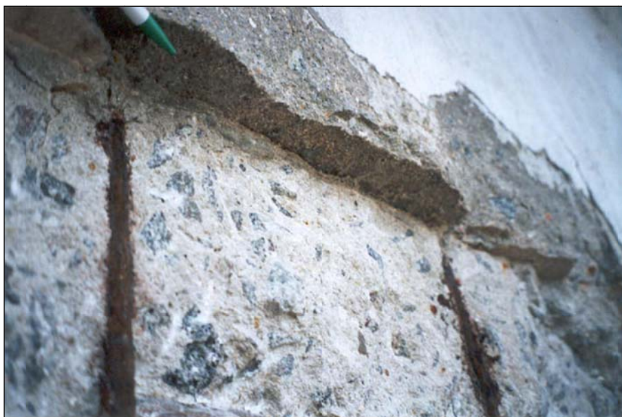
Fotografia 19 – Viga longarina L2, vão 2. Notar estribos corroídos e linha horizontal de fratura do concreto denotando região de junta de concretagem. O exame visual minucioso indica claramente a existência de duas camadas distintas de concreto e a concentração de pasta de cimento no topo da camada inferior, gerada por exsudação.
