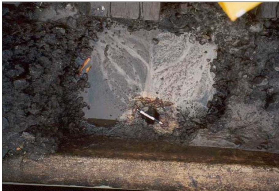
Fotografia 6 – Vista superior, lateral NO. Notar exposição da laje e furo de drenagem (buzinote).
