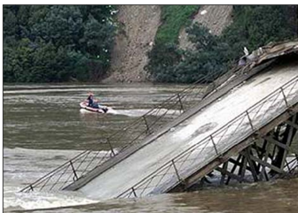
Figura 5 – Parte do tabuleiro da ponte sobre o Rio Douro que ruiu devido à perda de confinamento e ruptura das estacas de fundação (RIBEIRO, 2001).
