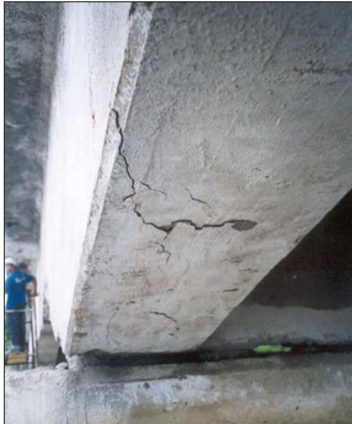
Fotografia 13 – Viga longitudinal L2, apoio sobre pilar P1. Detalhe do destacamento do concreto no fundo da viga devido à expansão dos produtos de corrosão dos estribos.
