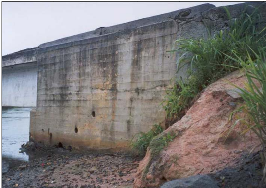
Fotografia 4 – Vista lateral, encontro E2 (Itabira), face SE.
