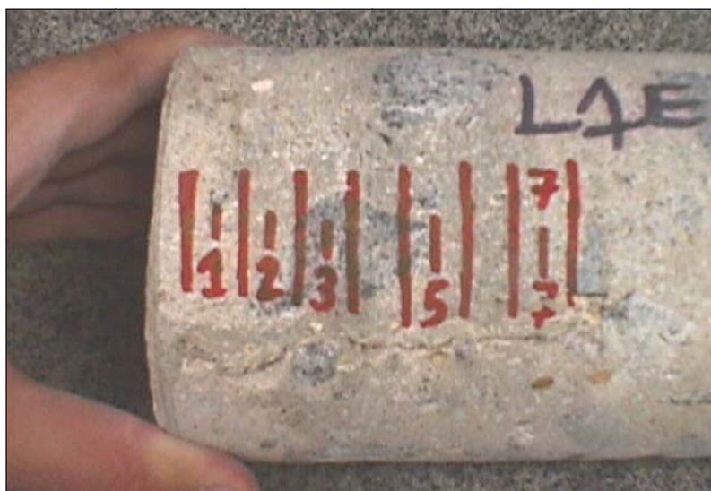
Figura 28 – Demarcação longitudinal de testemunho extraído para corte de fatias em distintas profundidades para a determinação do teor de cloretos.
