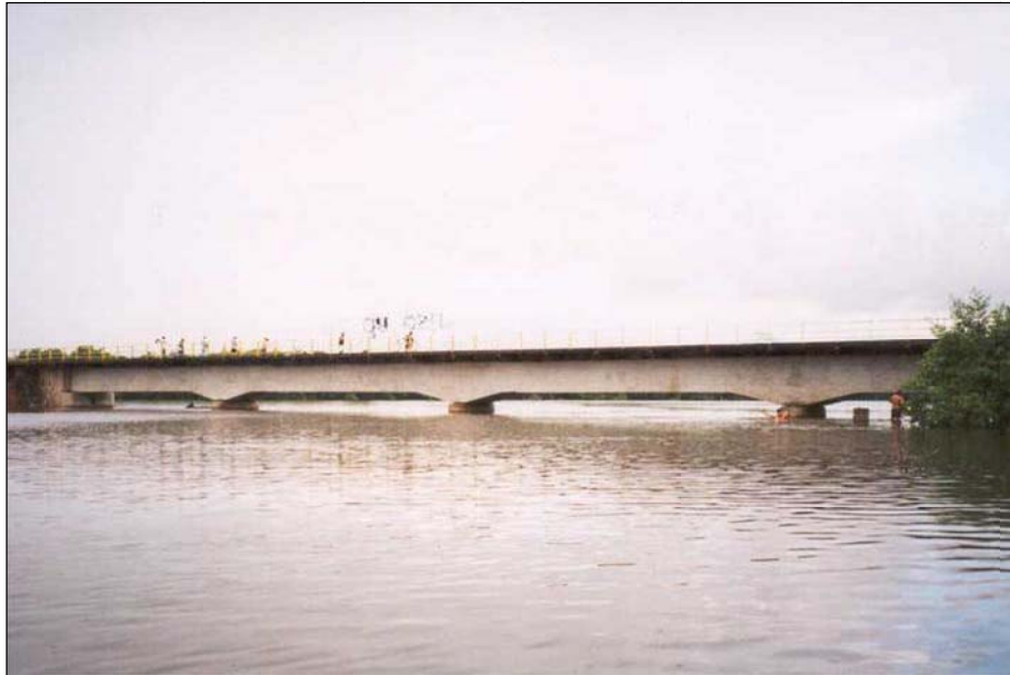
Fotografia 1 – Vista lateral panorâmica, face noroeste, sentido NO – SE.
