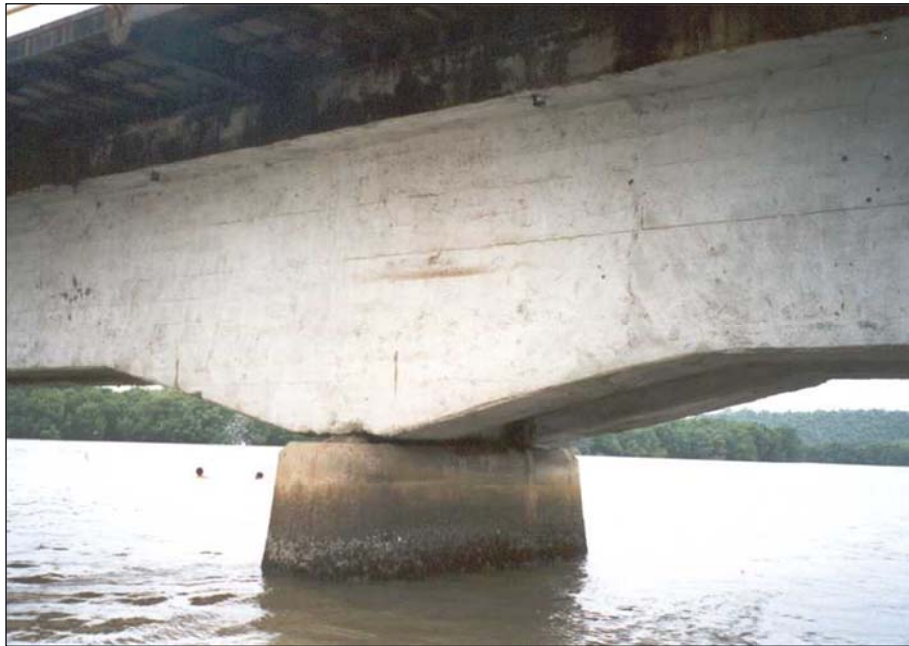
Fotografia 3 – Vista lateral, face noroeste, apoio sobre pilar P2.
