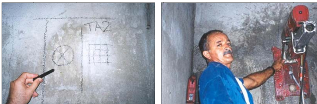
Figura 26 – Demarcação de local de extração de testemunho de concreto (entre estribos) e extração de testemunho (100 mm de diâmetro).
