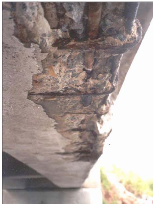
Fotografia 16 – Viga longarina L1, vão 4. Vista longitudinal inferior do fundo da viga, após remoção do concreto destacado e exposição das armaduras corroídas e ninhos de concretagem.
