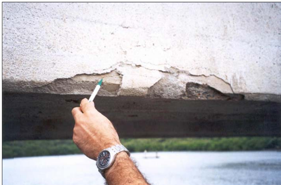
Fotografia 12 – Viga longarina L1, vão 2. Remoção da camada de chapisco projetado que apresenta baixa aderência ao concreto original da estrutura.
