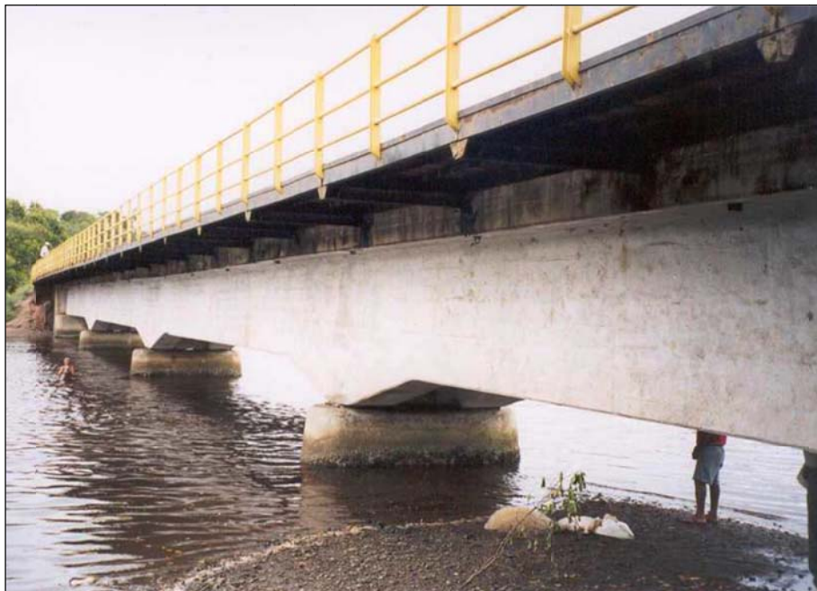
Fotografia 2 – Vista lateral, face nordeste, sentido SO – NE.
