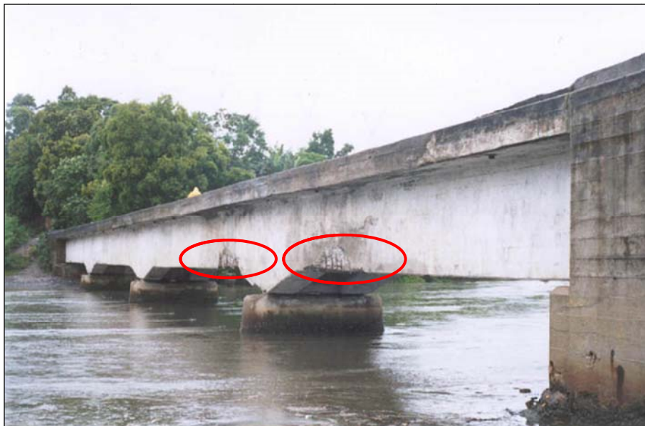
Fotografia 24 – Viga longarina L2, vista longitudinal, sentido NE – SO. Vista geral de duas áreas selecionadas para estudo detalhado após remoção do concreto destacado e exposição das armaduras corroídas.
