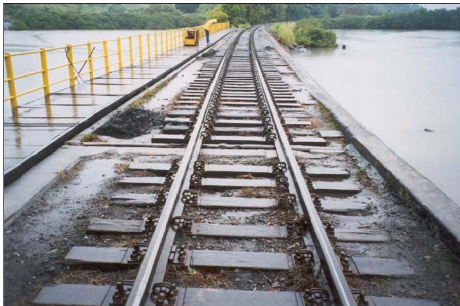
Fotografia 10 – Vista longitudinal superior, sentido SO – NE.
