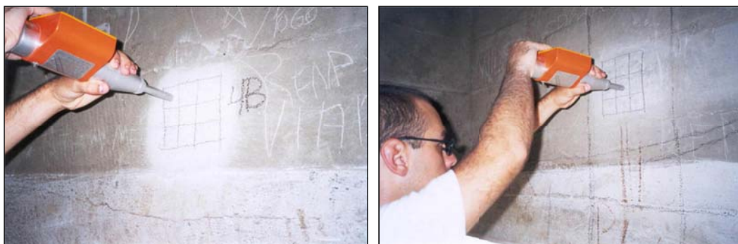
Figura 24 – Ensaio de dureza superficial do concreto com esclerômetro de reflexão.
