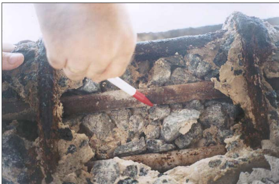
Fotografia 17 – Viga longitudinal L1, vão 3. Detalhe de grande ninho de concretagem no fundo da viga. Notar o acúmulo de argamassa abaixo das armaduras e de agregados graúdos acima das mesmas, indicando falha nas etapas de mistura, lançamento e adensamento do concreto, pois a compactação foi ineficiente e os agregados estão pouco envolvidos pela argamassa do concreto, além de terem sido retidos sobre as armaduras longitudinais. Notar também que as armaduras não estão envolvidas pelo concreto, o que compromete totalmente a aderência entre esses materiais.
