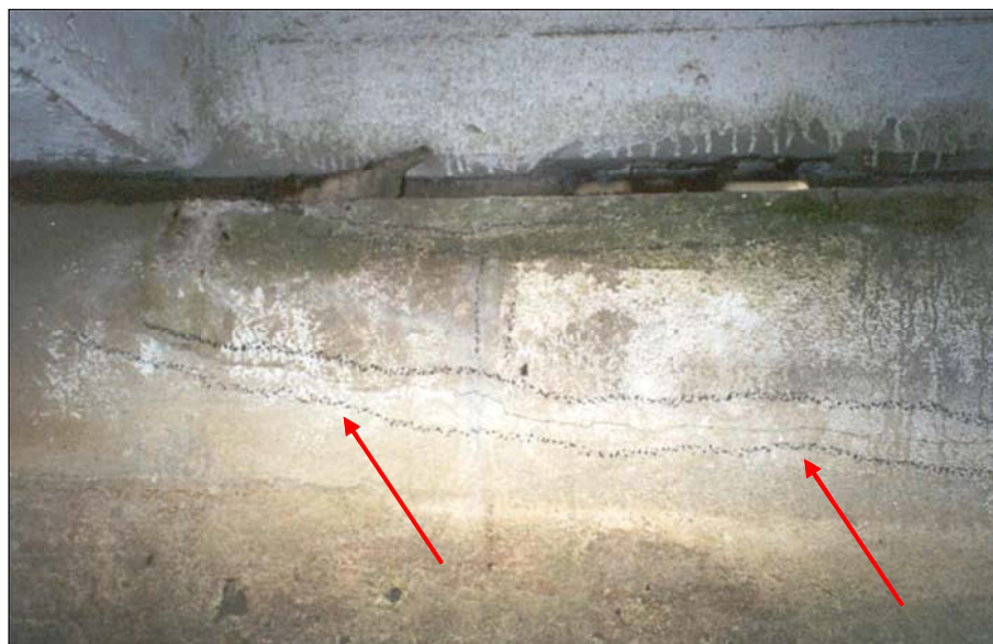
Fotografia 26 – Apoio da viga longitudinal L1 sobre o pilar P2. Notar fissuração do talha-mar.
