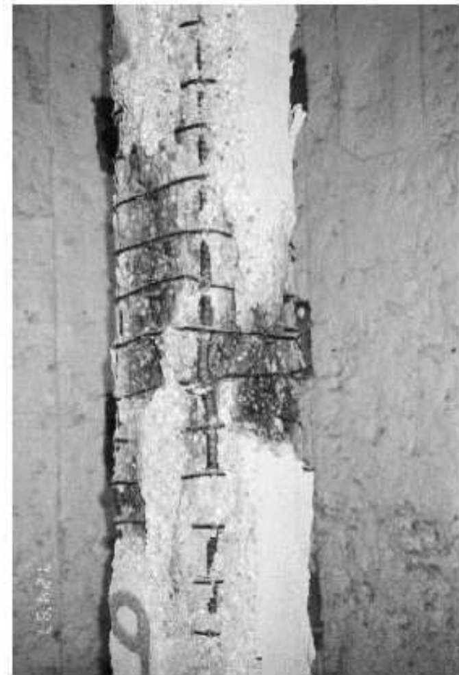
Configuração Modificada de Estribos
