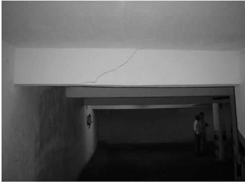
Trinca na viga do teto do subsolo junto a cisterna
