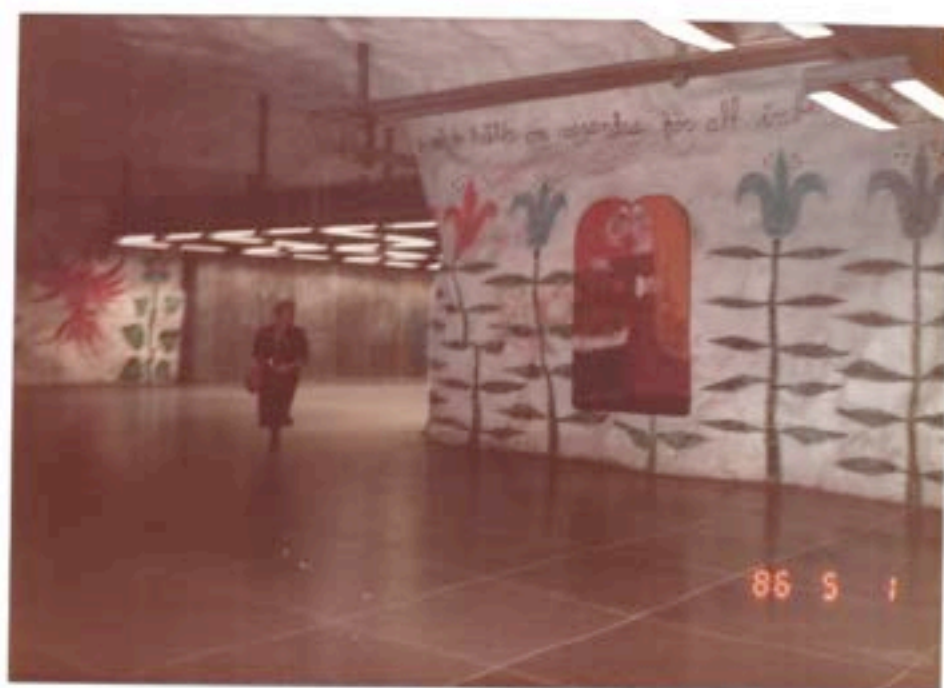
UTILIZAÇÃO DE CONCRETO PROJETADO COMO ESTRUTURA DEFINITIVA NO METRÔ DE ESTOCOLMO
