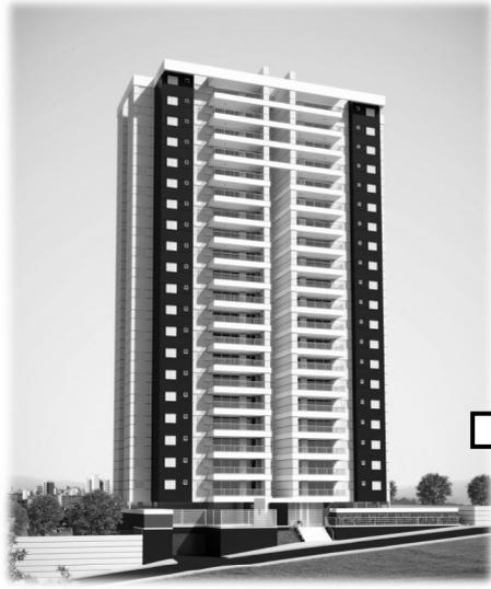
*Edificio residencial de estructura de concreto armado con 24 pisos tipo + 2 subsuelos.*
