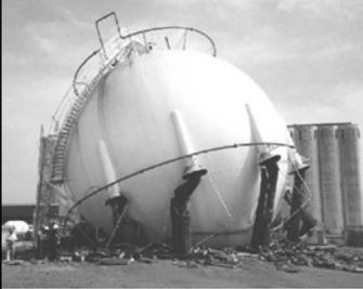
O acidente ocorreu devido a uma severa corrosão nas colunas de suporte devido à infiltração de água internamente à proteção contra fogo "Fire Proofing".
