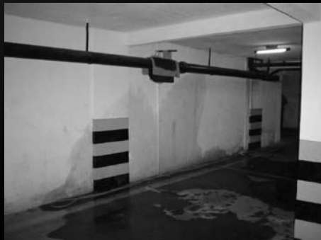
Vista geral do reservatório inferior e alagamento
