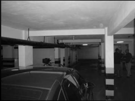
Vista geral do subsolo
