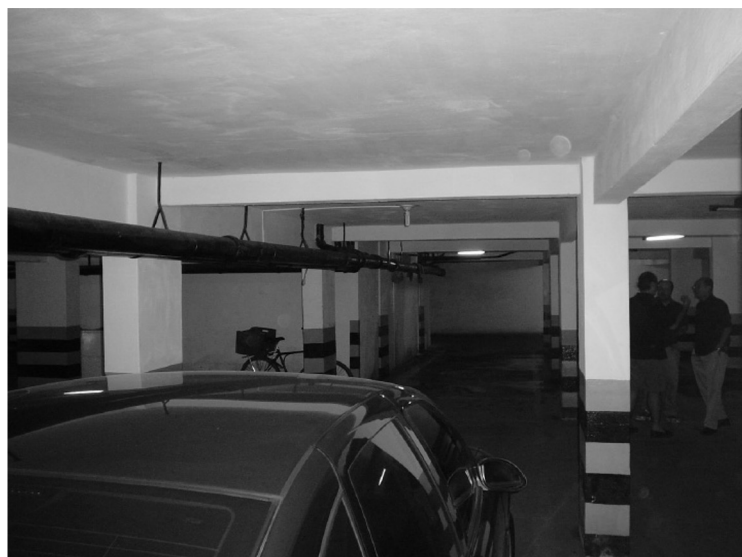
Vista geral do subsolo
