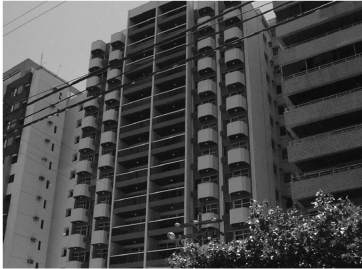
EDIFÍCIO AREIA BRANCA – Pernambuco
