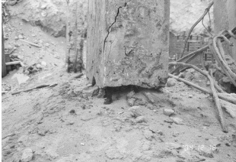
Ligação pilar - sapata com redução da seção transversal do pilar
