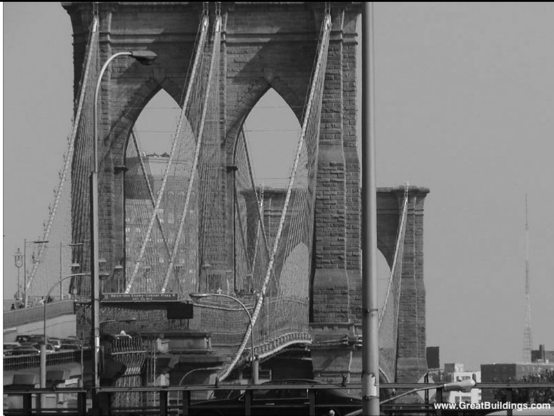
Ponte do Brooklyn, New York, USA → 1.883 John Augustus Roebling ponte suspensa com cabos de aço galvanizados
