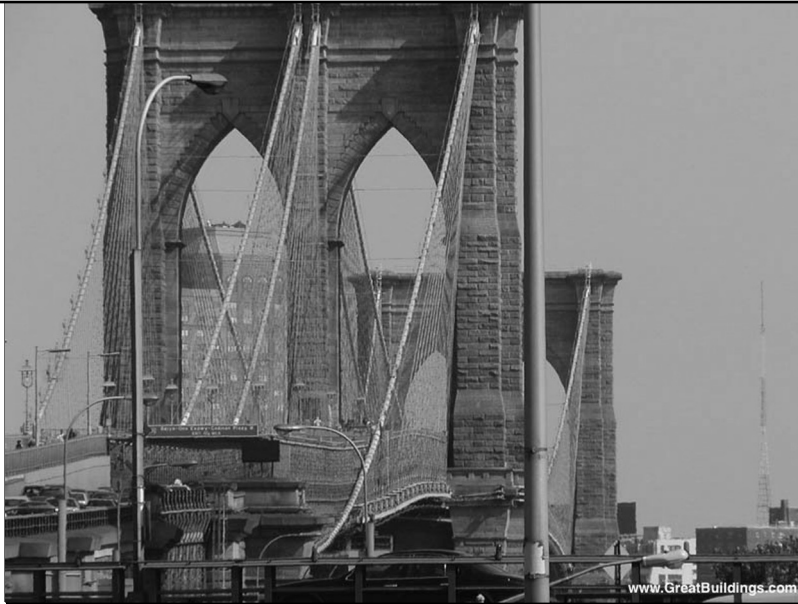
Ponte do Brooklin, New York, USA → 1.883 John Augustus Roebling ponte suspenso com cabos de aço galvanizados
