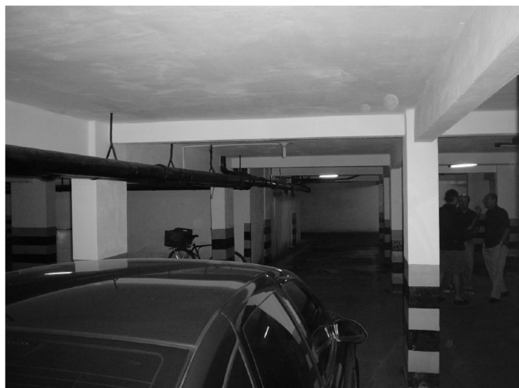
Vista geral do subsolo
