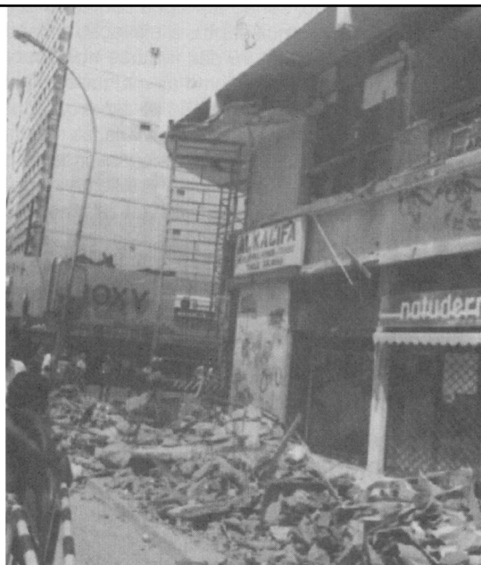
Detalhe para os tirantes em concreto armado no plano da fachada e para os escombros.
