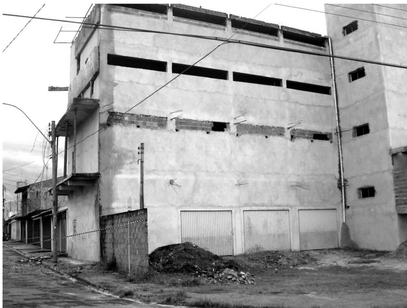
Vista da Edificação – Jardim Bicão – São Carlos
