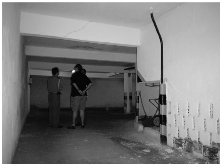
Moradores acompanham a vistoria efetuada pela Defesa Civil
