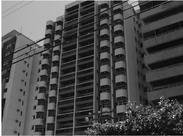
EDIFÍCIO AREIA BRANCA – Pernambuco
