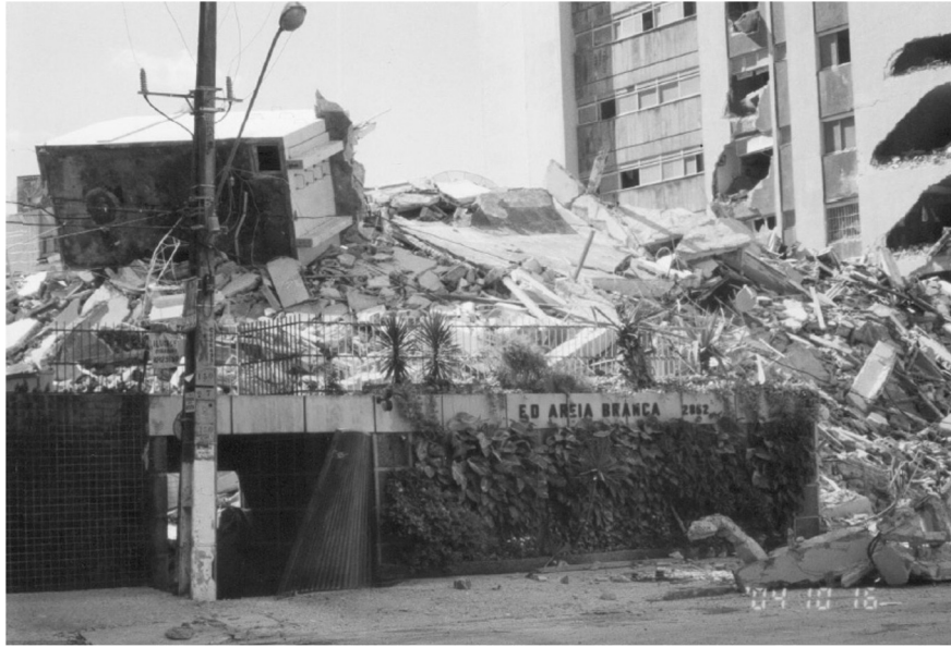
Escombros - manhã seguinte do desabamento
