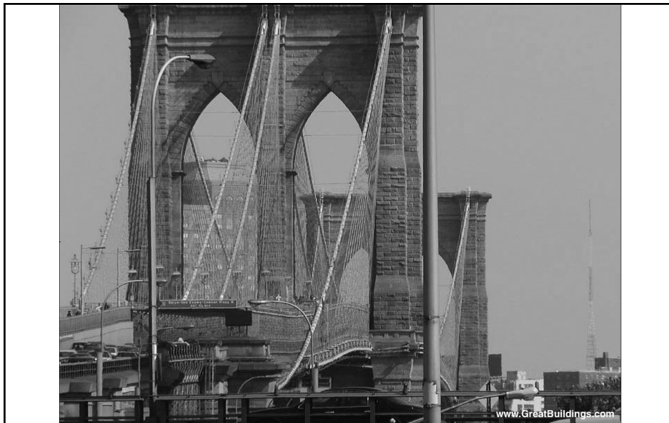
Ponte do Brooklyn, New York, USA → 1.883 John Augustus Roebling ponte suspensa com cabos de aço galvanizados
