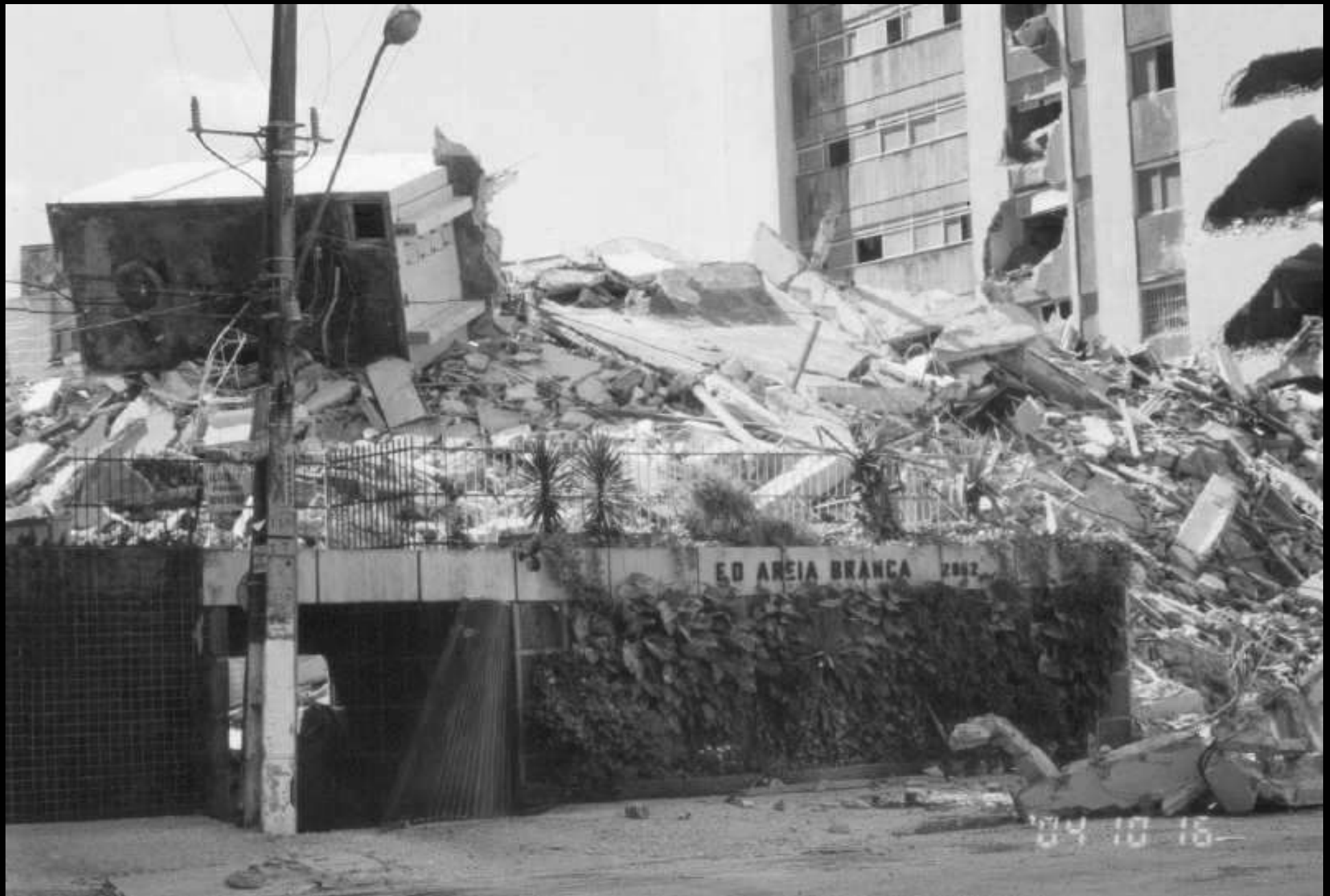
Escombros - manhã seguinte do desabamento
