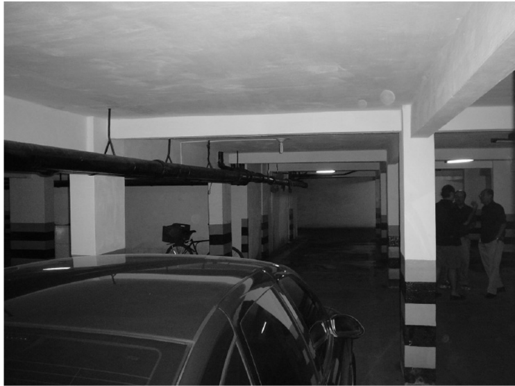
Vista geral do subsolo
