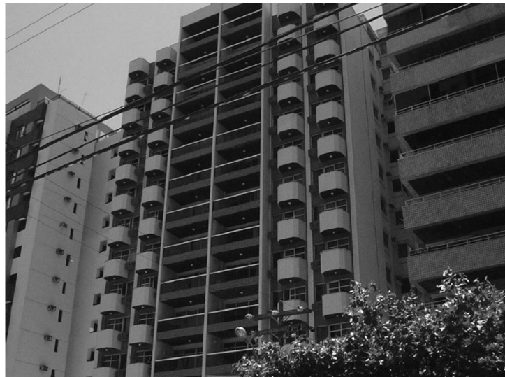
EDIFÍCIO AREIA BRANCA – Pernambuco
