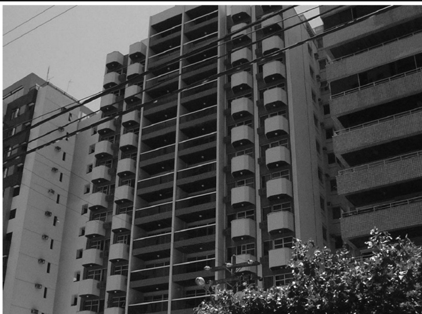
EDIFÍCIO AREIA BRANCA – Pernambuco
