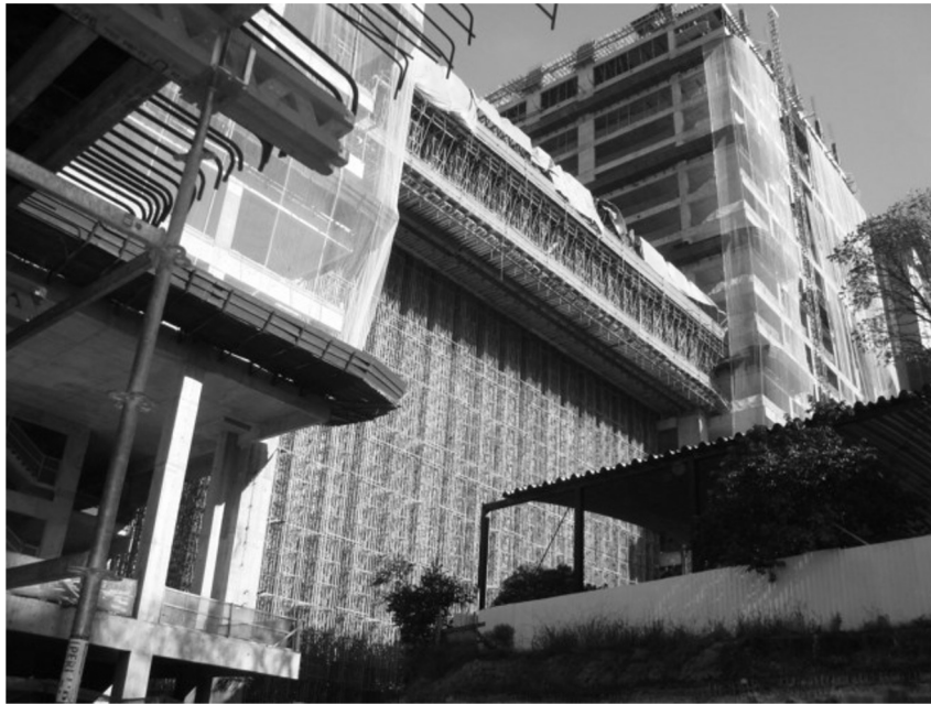
escoramento em balanço
