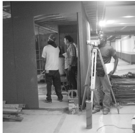
Controle contínuo de deslocamento vertical (recalque) dos pilares P4, P1A e P7
