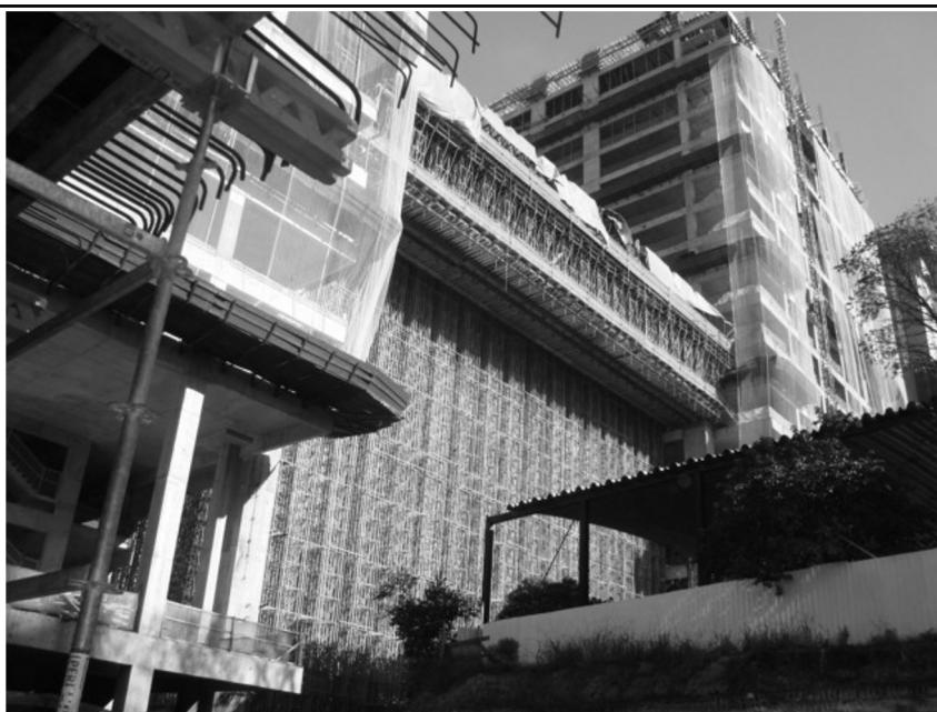
escoramento em balanço
