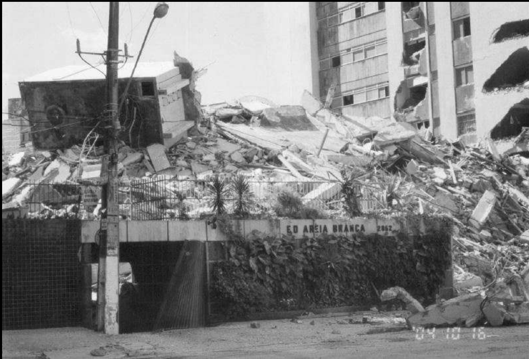
Escombros - manhã seguinte do desabamento
