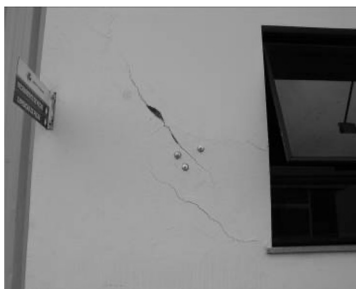
Vista da instrumentação instalada.
