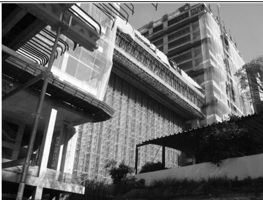
escoramento em balanço
