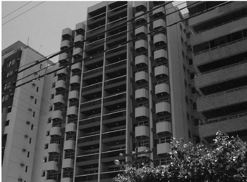
EDIFÍCIO AREIA BRANCA – Pernambuco
