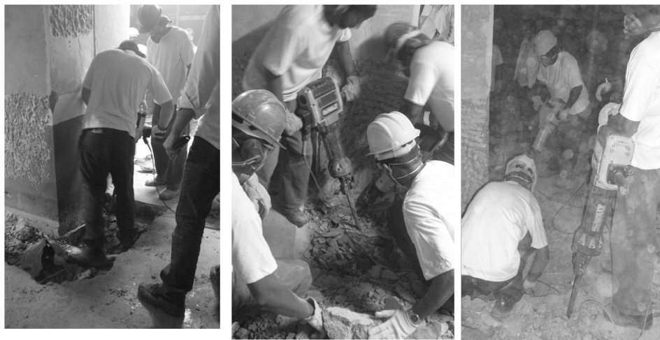
Demolição Piso fase 1
