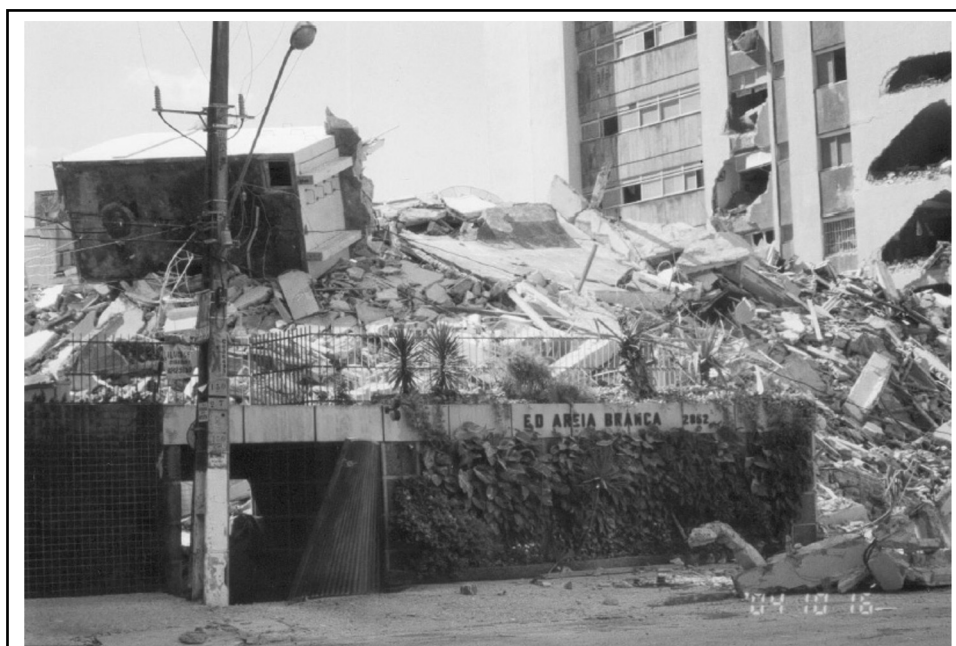
Escombros - manhã seguinte do desabamento
