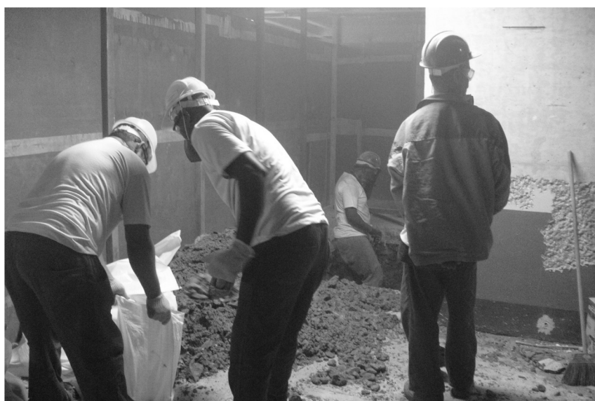
Escavação Piso fase 1
