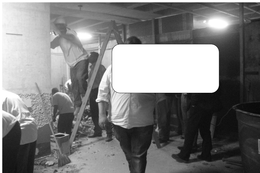
Escavação Piso fase 1
