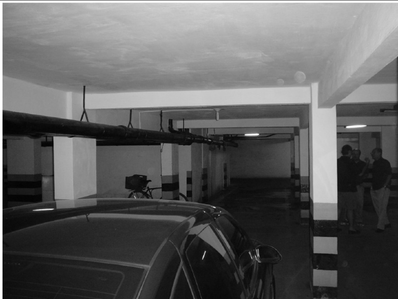
Vista geral do subsolo
