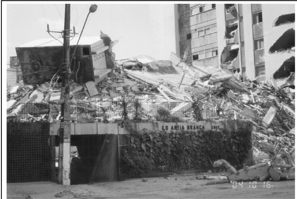
Escombros - manhã seguinte do desabamento
