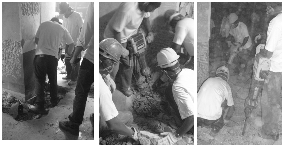
Demolição Piso fase 1
