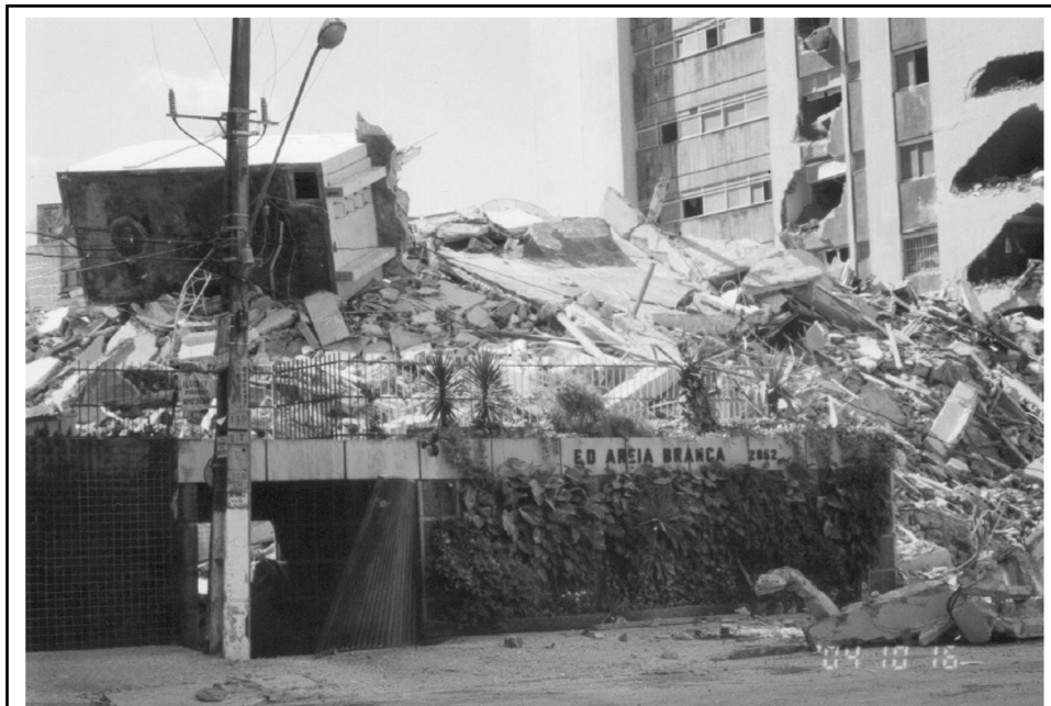
Escombros - manhã seguinte do desabamento
