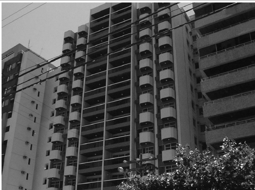
EDIFÍCIO AREIA BRANCA – Pernambuco
