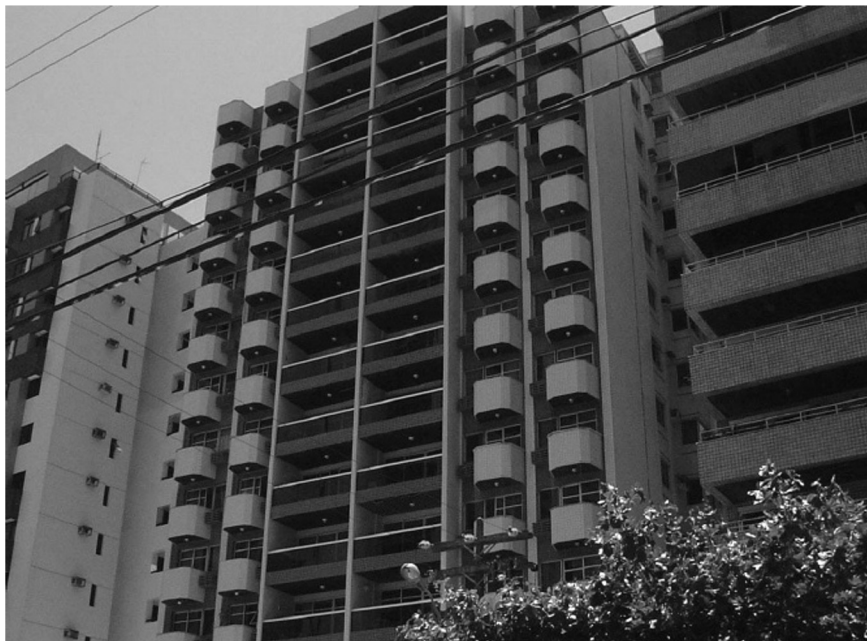
EDIFÍCIO AREIA BRANCA – Pernambuco
