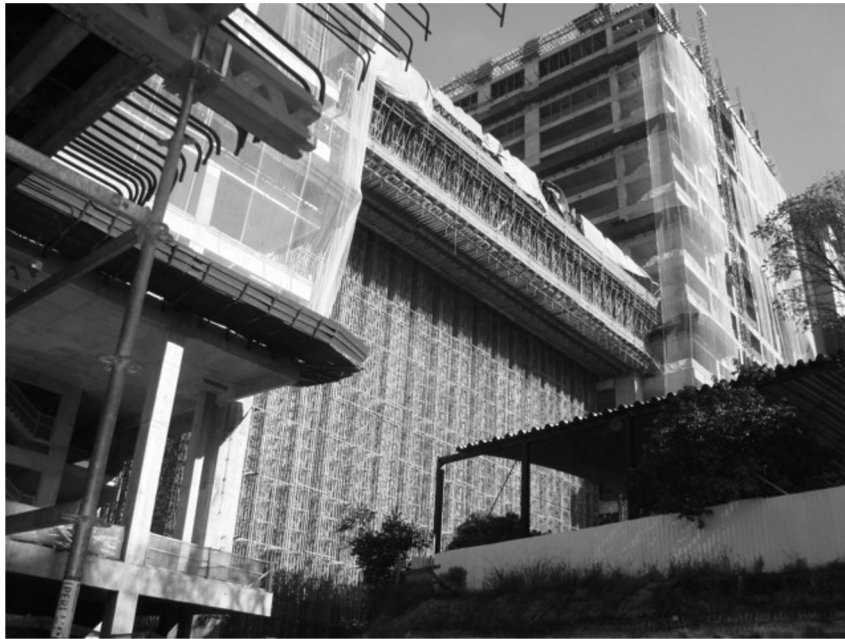
escoramento em balanço
