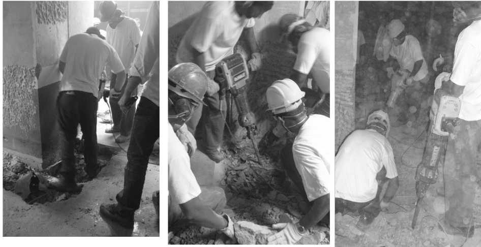
Demolição Piso fase 1
