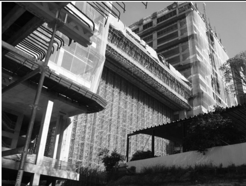
escoramento em balanço
