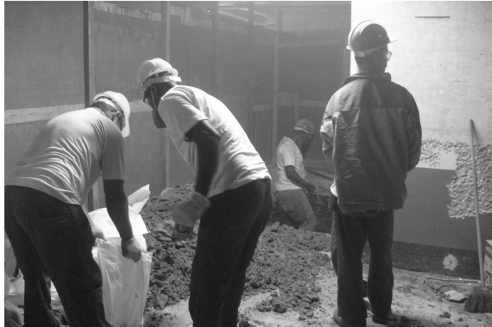
Escavação Piso fase 1
