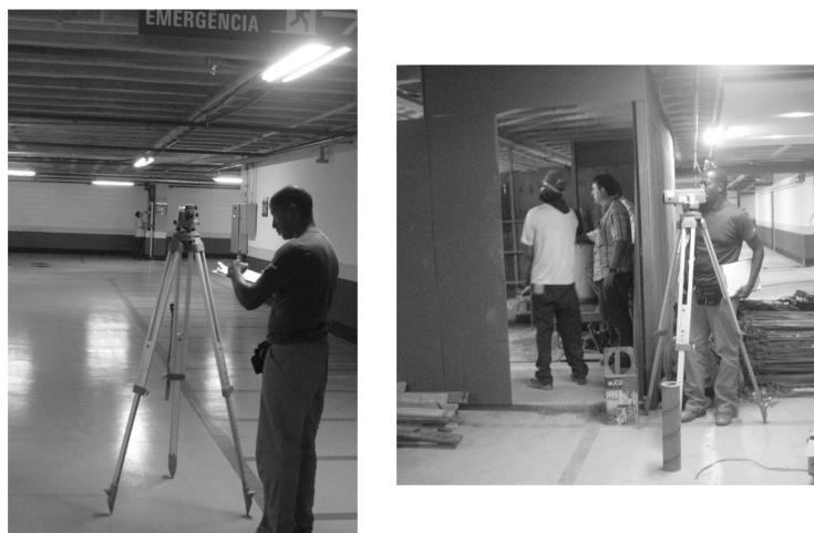
Controle contínuo de deslocamento vertical (recalque) dos pilares P1, P1A e P2
