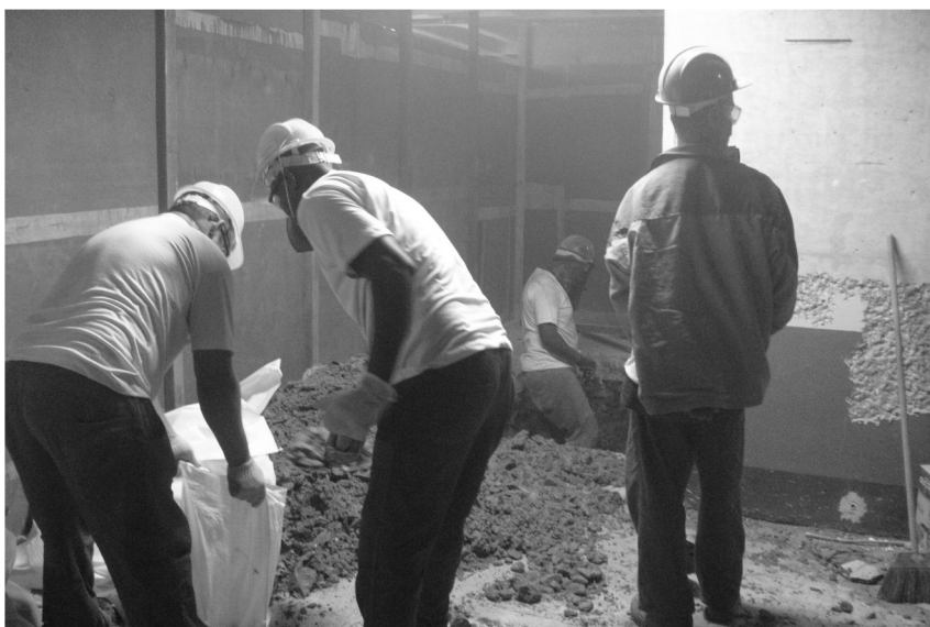
Escavação Piso fase 1
