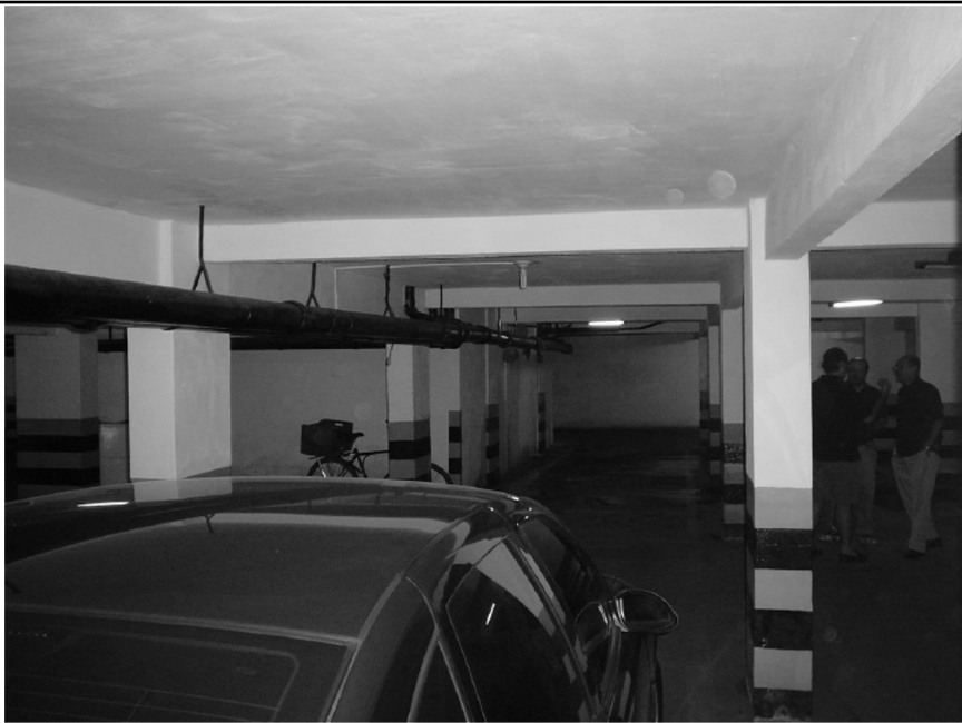
Vista geral do subsolo
