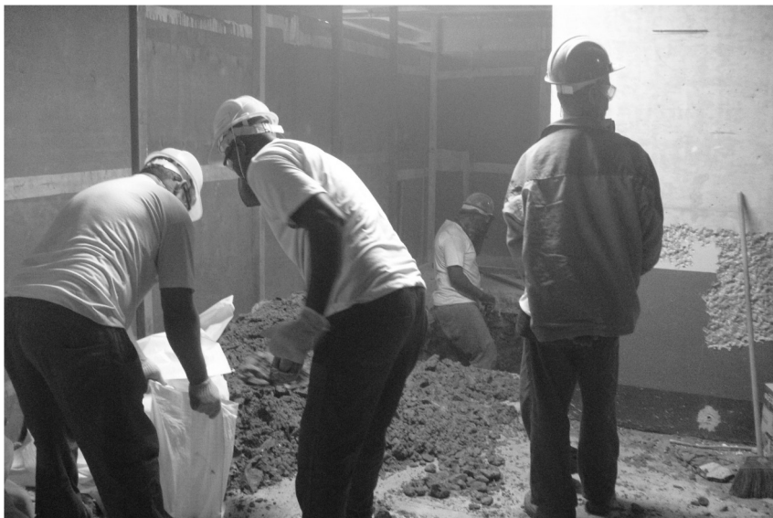
Escavação Piso fase 1
