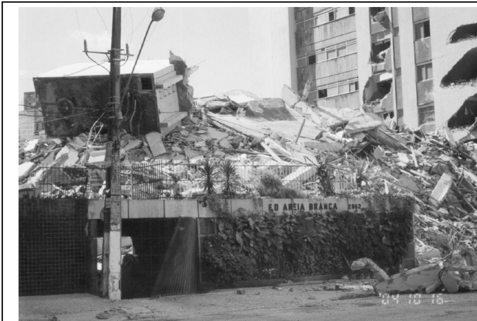
Escombros - manhã seguinte do desabamento
