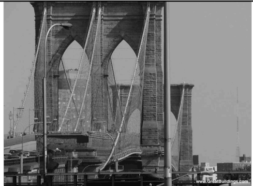
Puente del Brooklyn, New York, USA → 1883 John Augustus Roebling ponte suspensa com cabos de aço galvanizados
