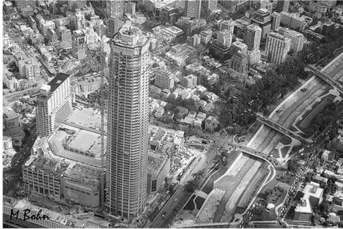
Torre Gran Costanera 70 pisos Santiago de Chile 300m recorde Ibero Americano Febrero 2012 → inauguración 2013
