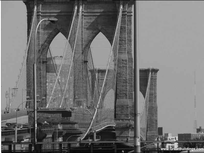
Puente del Brooklyn, New York, USA → 1.883 John Augustus Roebling ponte suspenso com cabos de aço galvanizados
