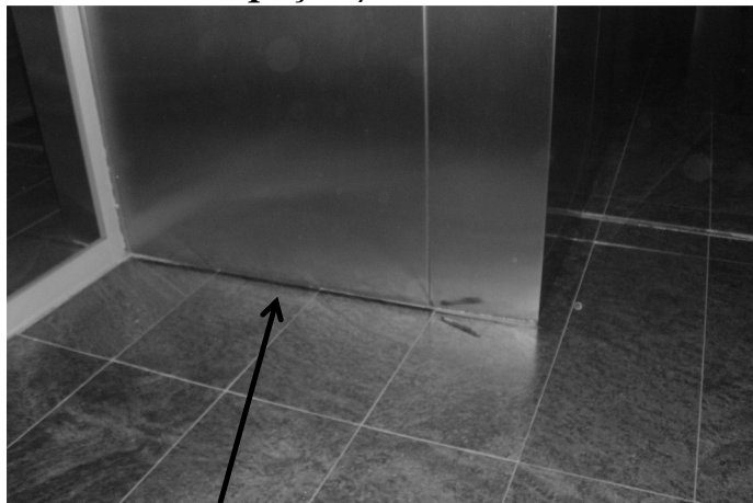
Desnívelamento nível S2
