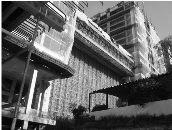
escoramento em balanço
