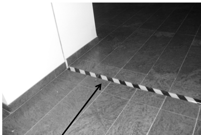
Desnívelamento nível S3
