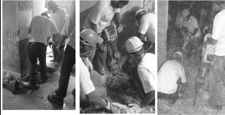
Demolição Piso fase 1
