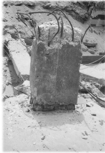
Ligação pilar - sapata com redução da seção transversal do pilar
