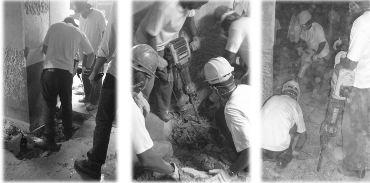
Demolição Piso fase 1
