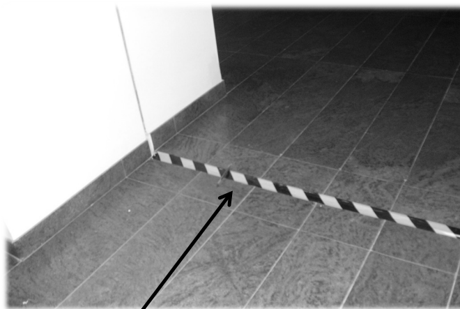
Desnívelamento nível S3
