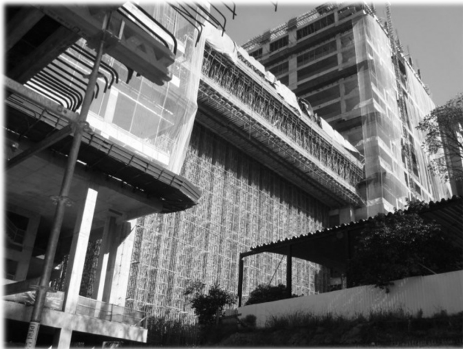
escoramento em balanço
