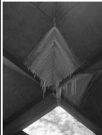
Cobertura do Prédio da FAU-USP
