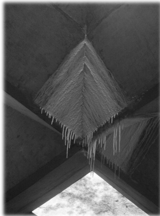
Cobertura do Prédio da FAU-USP
