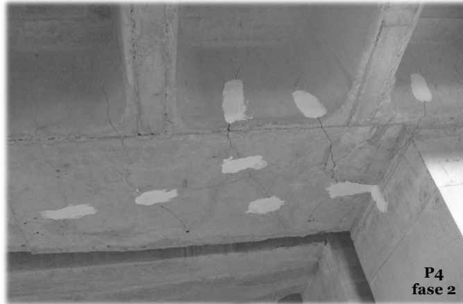
Fissuras em Vigas
