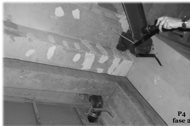
Fissuras em Vigas
