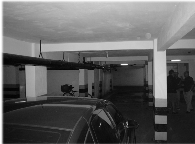
Vista geral do subsolo
