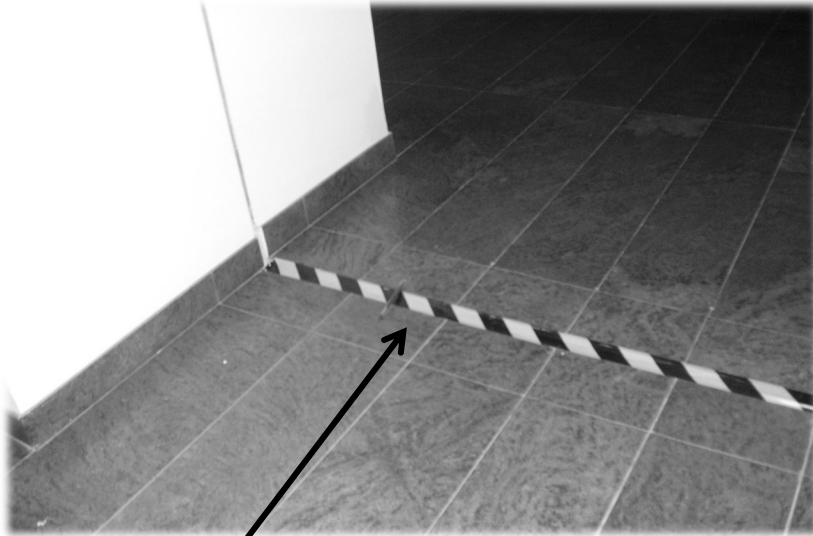
Desnívelamento nível S3
