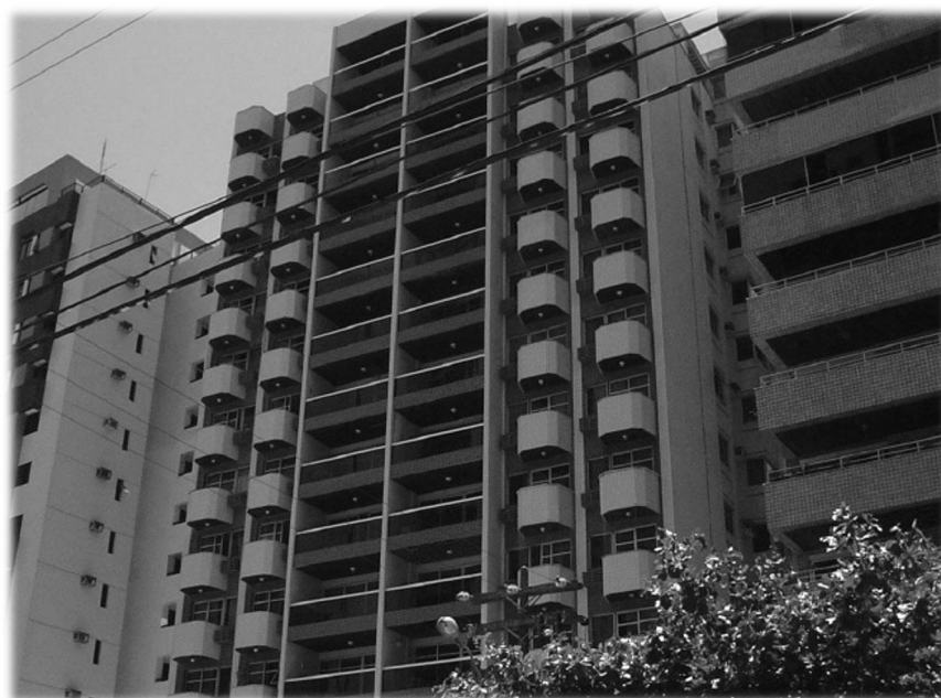
EDIFÍCIO AREIA BRANCA – Pernambuco
