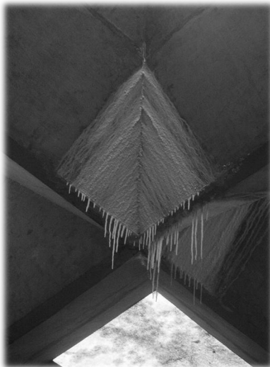
Cobertura do Prédio da FAU-USP
