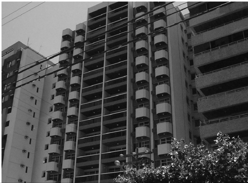
EDIFÍCIO AREIA BRANCA – Pernambuco
