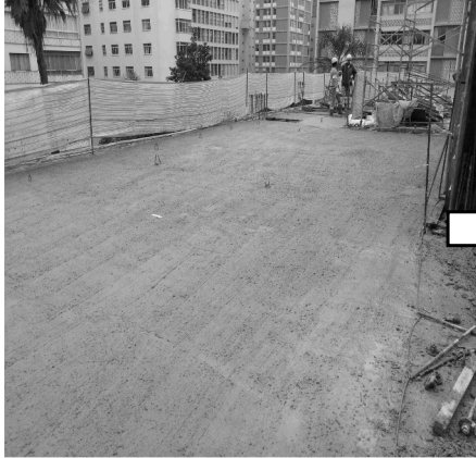
Laje sem procedimento de cura adequado.
