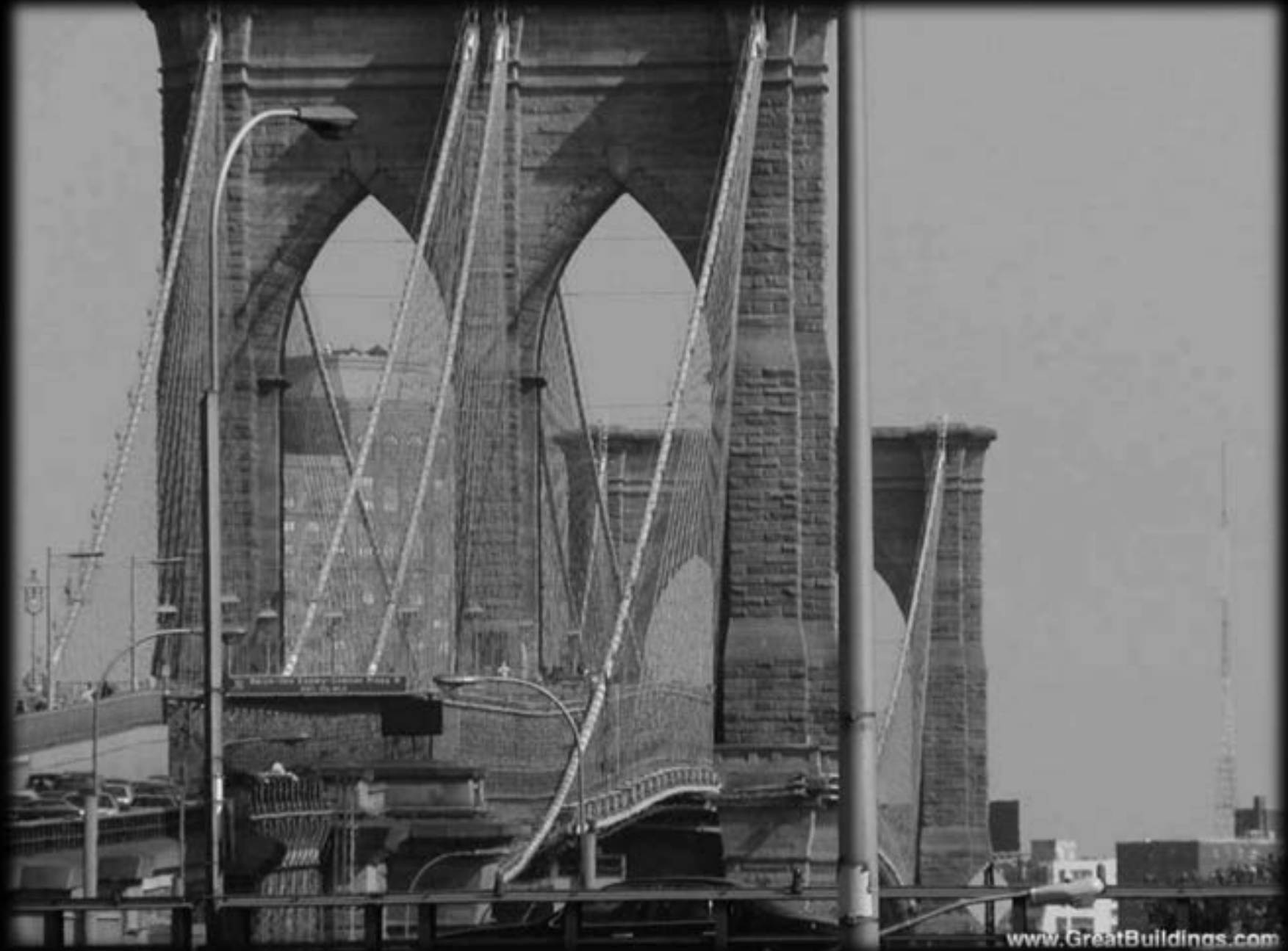
Ponte do Brooklin, New York, USA → 1.883 John Augustus Roebling ponte suspensa com cabos de aço galvanizados
