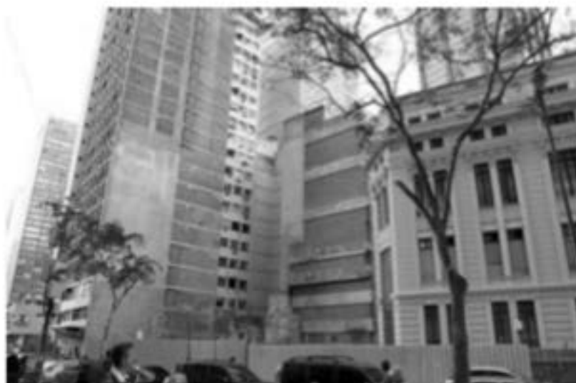
Avenida Treze de Maio, no local onde desabaram prédios no dia 25 de janeiro (DOMINGOS PEREIRA / AGÊNCIA O GLOBO)
