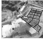
Figura 1 – Distribuição dos setores da região colapsada.
