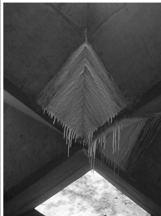
Cobertura do Prédio da FAU-USP
