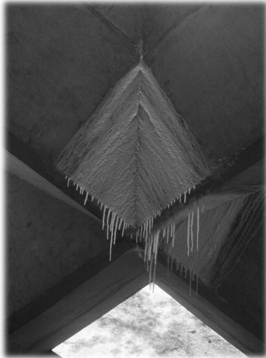
Cobertura do Prédio da FAU-USP
