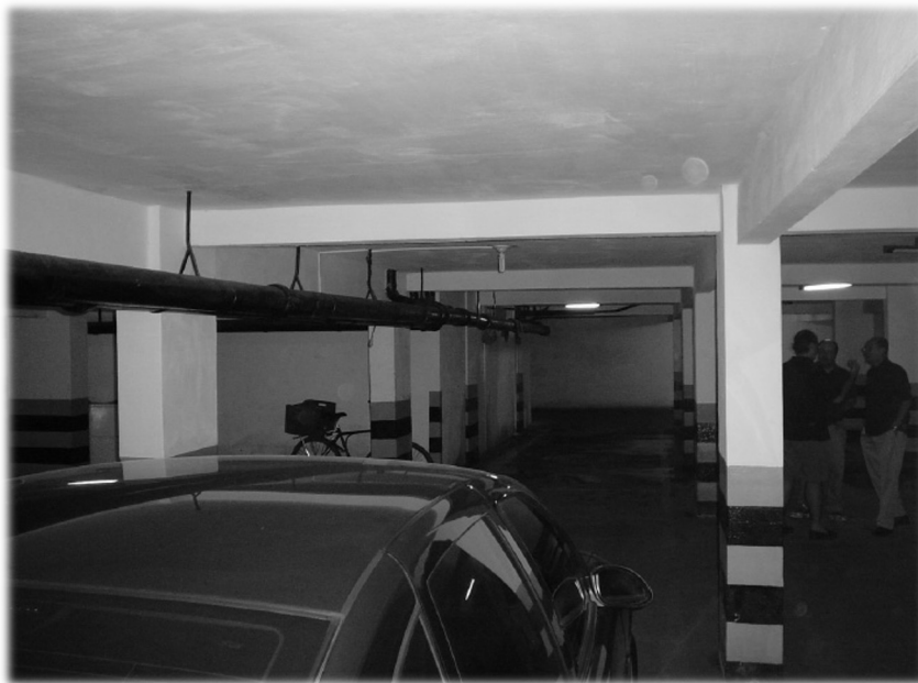
Vista geral do subsolo
