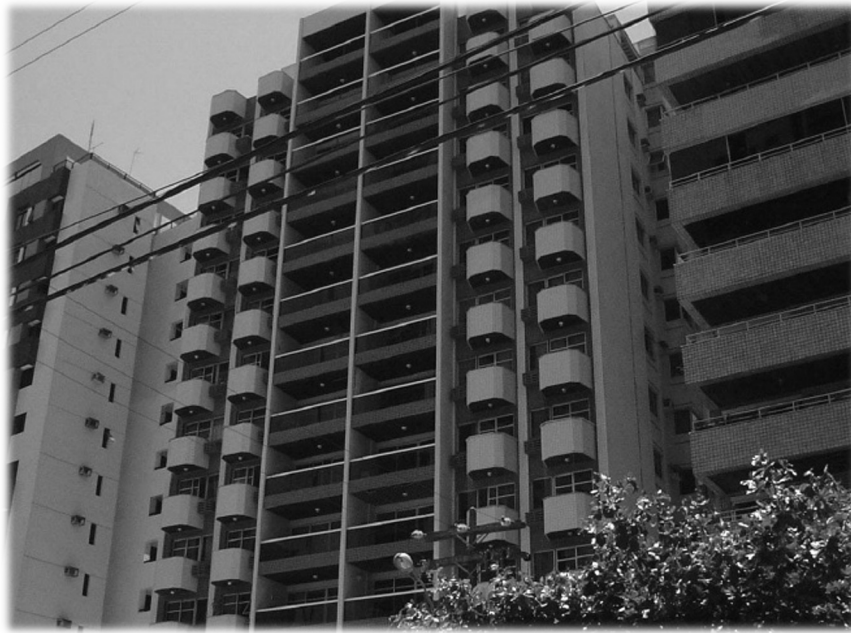
EDIFÍCIO AREIA BRANCA – Pernambuco
