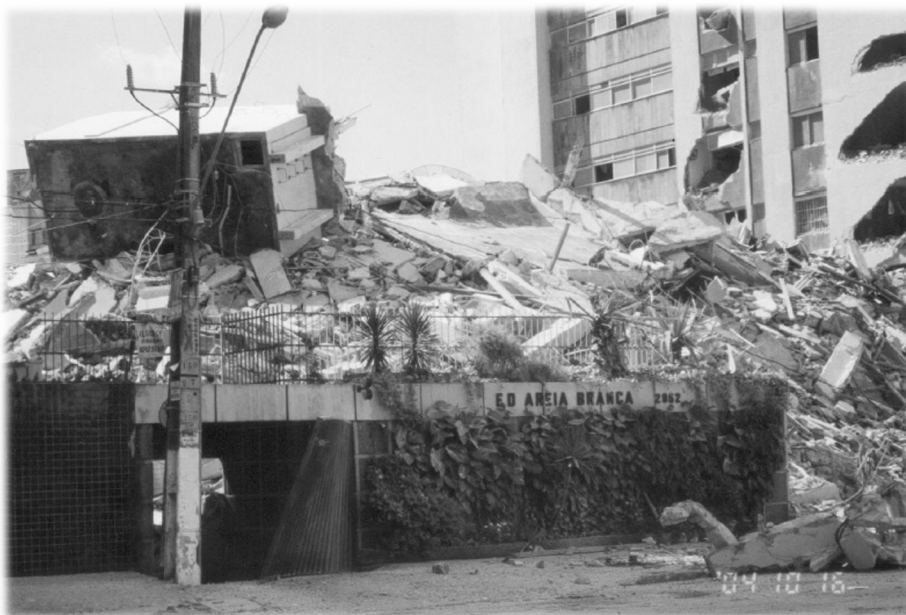
Escombros - manhã seguinte do desabamento
