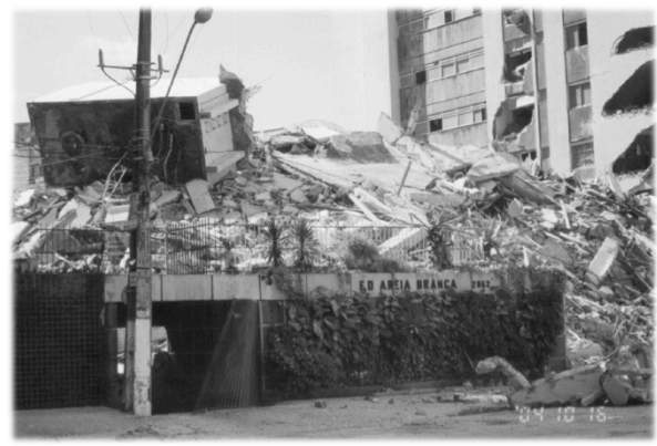
Escombros - manhã seguinte do desabamento
