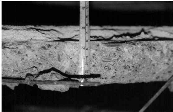
espessura da laje suplementar
