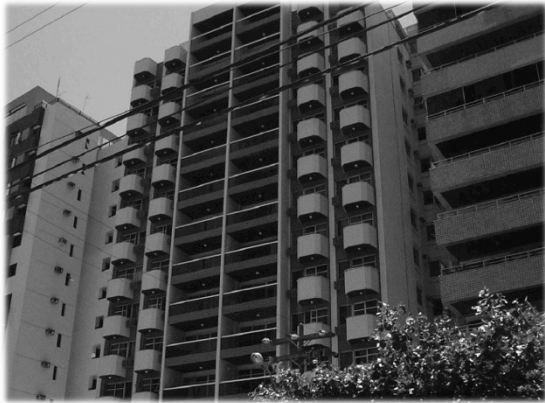
EDIFÍCIO AREIA BRANCA – Pernambuco
