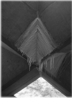
Cobertura do Prédio da FAU-USP
