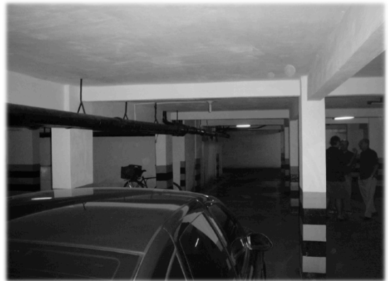
Vista geral do subsolo
