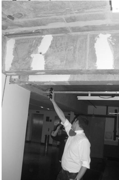
**Desnivelamento e fissuras em vigas**
