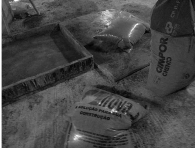
Todo reparo estrutural deve ser realizado com argamassa, graute ou concreto com resistência bem superior à da peça. No mínimo **PhD Engenharia**
