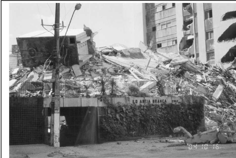
Escombros - manhã seguinte do desabamento
