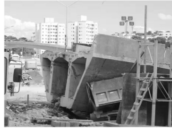
O viaduto despencou e atingiu um micro-ônibus, um carro e dois caminhões
