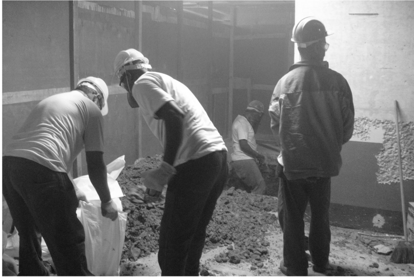
Escavação Piso fase 1
