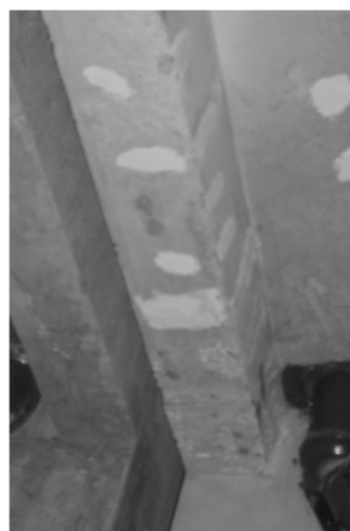
colagem de plaquetas de vidro 2mm para controle de eventual movimento de fissuras
