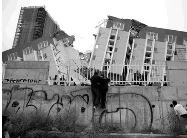
Colapso de Edificio Alto Rio recién entregado en Concepción (terremoto en 2010)
